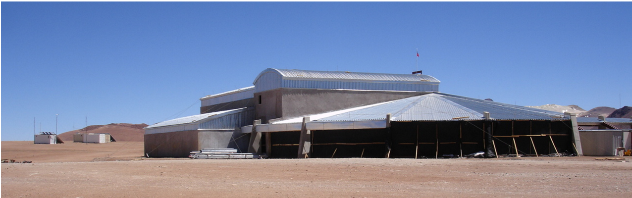
El Edificio Técnico del AOS o Sitio de Operaciones del Conjunto es el que albergará elementos tales como el correlador de ALMA. Foto © NAOJ
